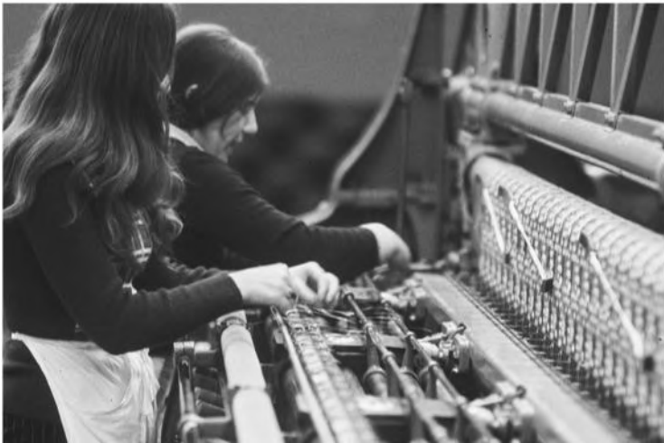
Einziehen des Garnes in die Sticknadeln einer Stickmaschine.
